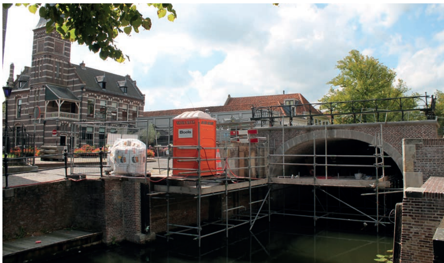
De werksteiger aan de oostzijde van de Damsluis.
