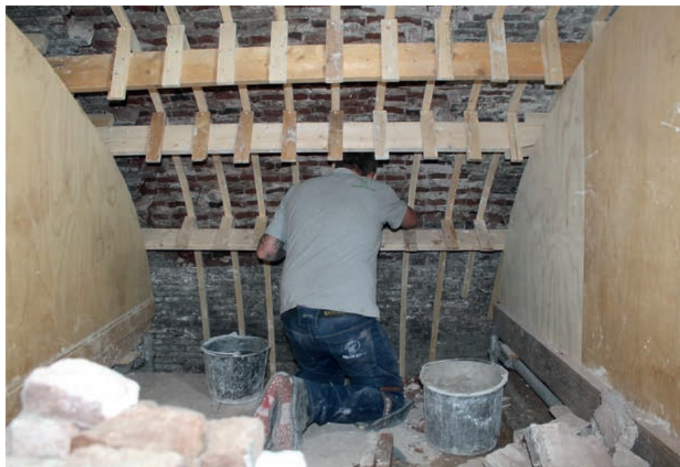
Restauratiemetselaar Maikel Wagner is tussen de schotten bezig met herstelwerkzaamheden.
