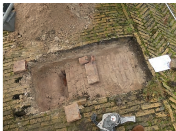
Op locatie zijn proefgaten gemaakt.
