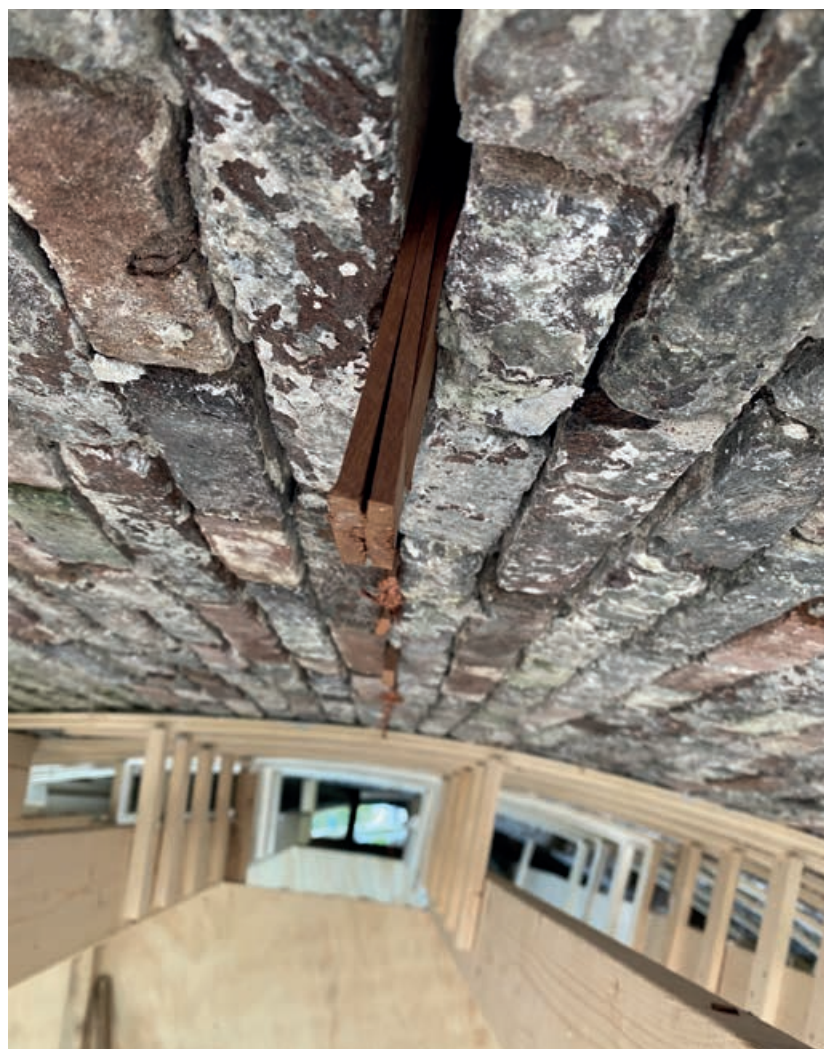
Omdat het nauwelijks mogelijk is de laatste voeg met specie te metselen, wordt deze gevuld met specie uit een soort grote kitspuit. De wiggen zitten er tijdelijk.
