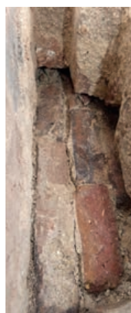
In deze proefopening zie je een open ruimte van enkele centimeters in het vlak van de boog.
