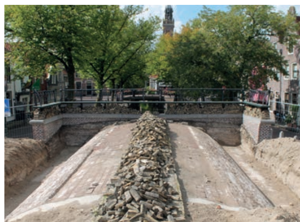
Bovenaanzicht op het tongewelf, dat gewoonlijk onder de straatklinkers verborgen ligt.
