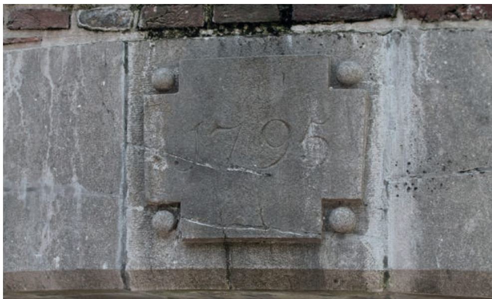
De brug heeft haar huidige vorm gekregen in de jaren 1795-1798, blijktens de jaartallen in de sluitstenen van de frontmuren.
